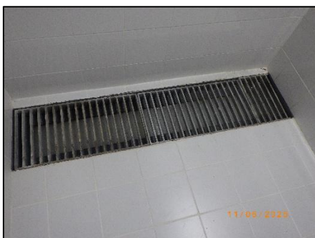
รูปที่ 2-20 ท่อรวบรวมน้ำเสีย บริเวณห้องพักมูลฝอยรวม
