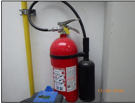
รูปที่ 2-30 ถังดับเพลิงมือถือชนิดคาร์บอนไดออกไซด์
