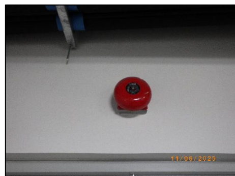
รูปที่ 2-37 กริ่งสัญญาณเตือนอัคคีภัย
