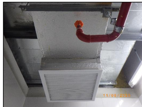
พัดลมดูดอากาศจากห้องพักมูลฝอยเปียก
