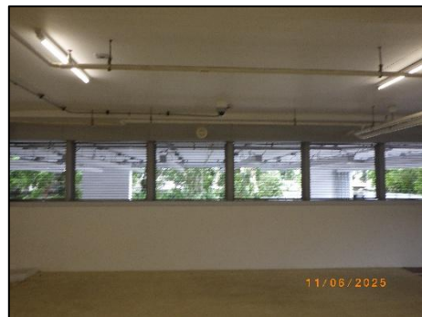
รูปที่ 2-3 ช่องระบายอากาศในพื้นที่จอดรถ
