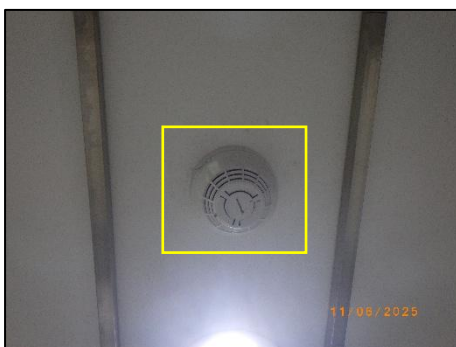
รูปที่ 2-34 เครื่องตรวจจับควัน
