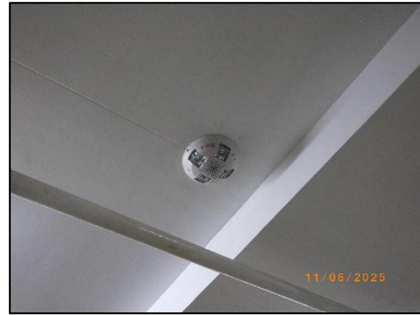
รูปที่ 2-38 อุปกรณ์แจ้งเหตุด้วยเสียงและแสง
