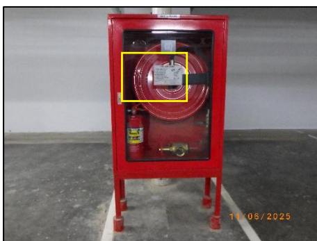
รูปที่ 2-60 ติดป้ายแนะนำการใช้อุปกรณ์สายดับเพลิงนอกอาคารพร้อมตู้เก็บ (FHC)
