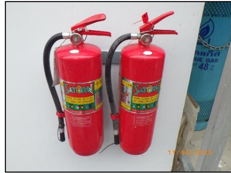
รูปที่ 2-31 ถังดับเพลิงเคมีแห้งแบบมือถือ
