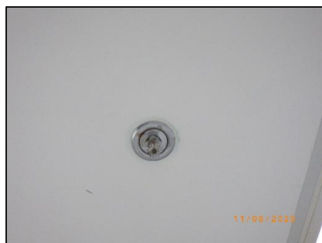
รูปที่ 2-27 ระบบหัวกระจายน้ำดับเพลิงอัตโนมัติ
