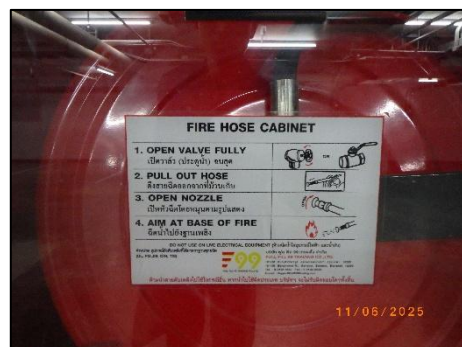
รูปที่ 2-60 ติดป้ายแนะนำการใช้อุปกรณ์สายดับเพลิงนอกอาคารพร้อมตู้เก็บ (FHC)
