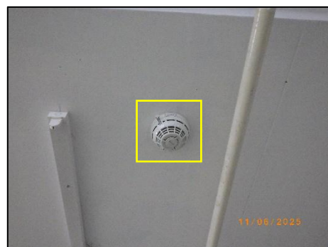
รูปที่ 2-35 เครื่องตรวจจับความร้อน
