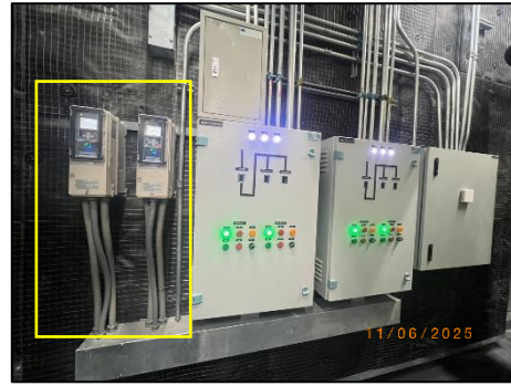
รูปที่ 2-63 อุปกรณ์ปรับความเร็วรอบมอเตอร์ VSD
